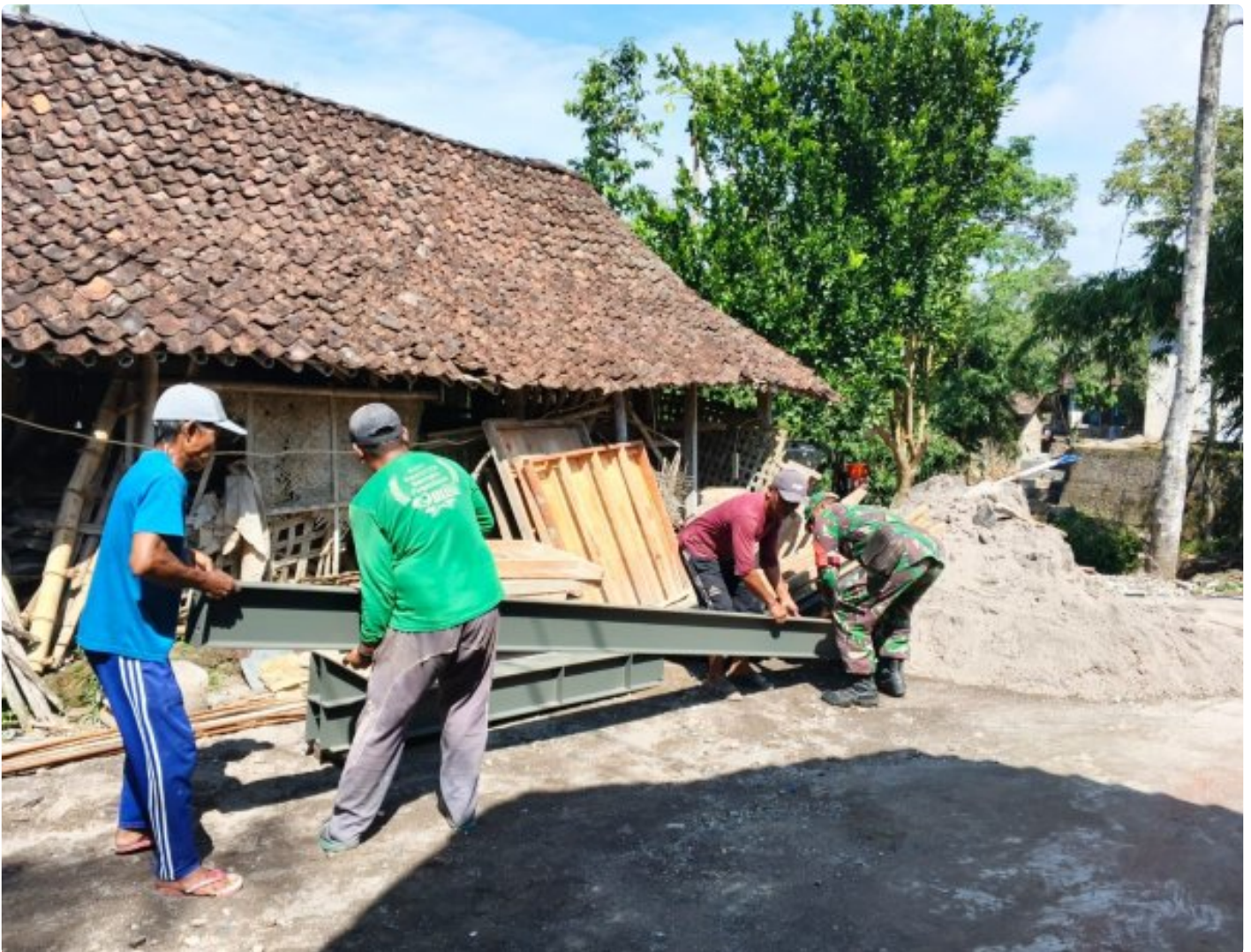
Babinsa Dan Warga Kompak Turunkan Tiang Pancang Jembatan Garuda
