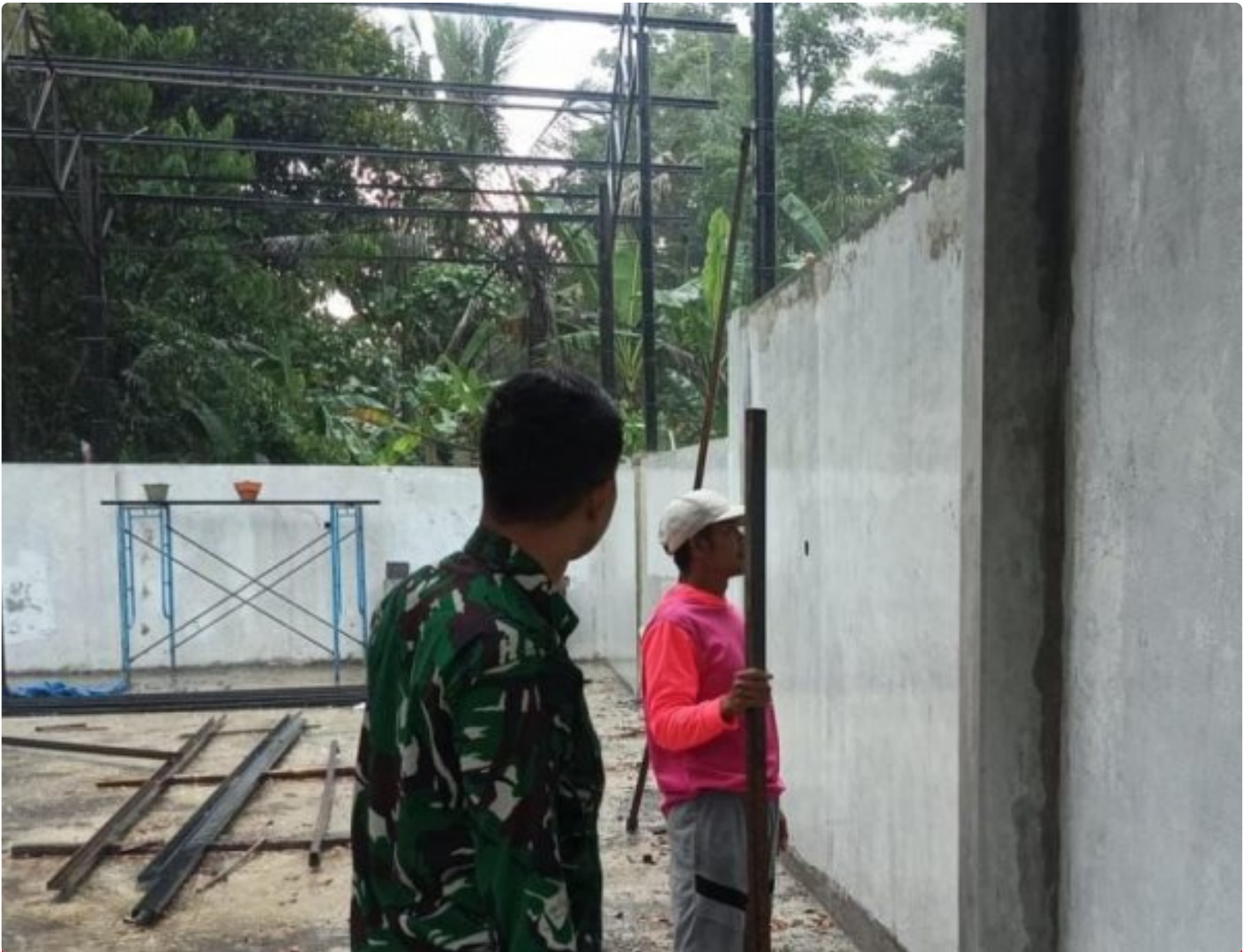
Babinsa Kodim Klaten Pantau Pembangunan Koperasi Desa
