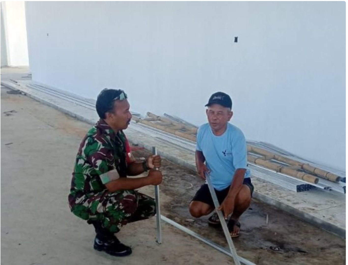
Babinsa Koramil 21/Juwiring Pastikan Pembangunan KDKMP Desa Taji Berjalan Lancar
