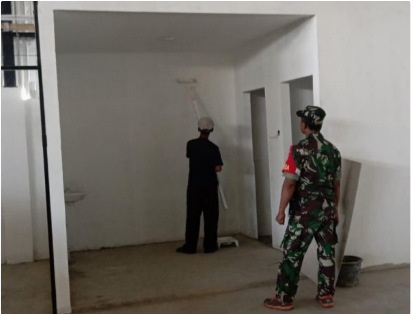
Babinsa Nangsri Pantau Pengecatan Gudang KDKMP
