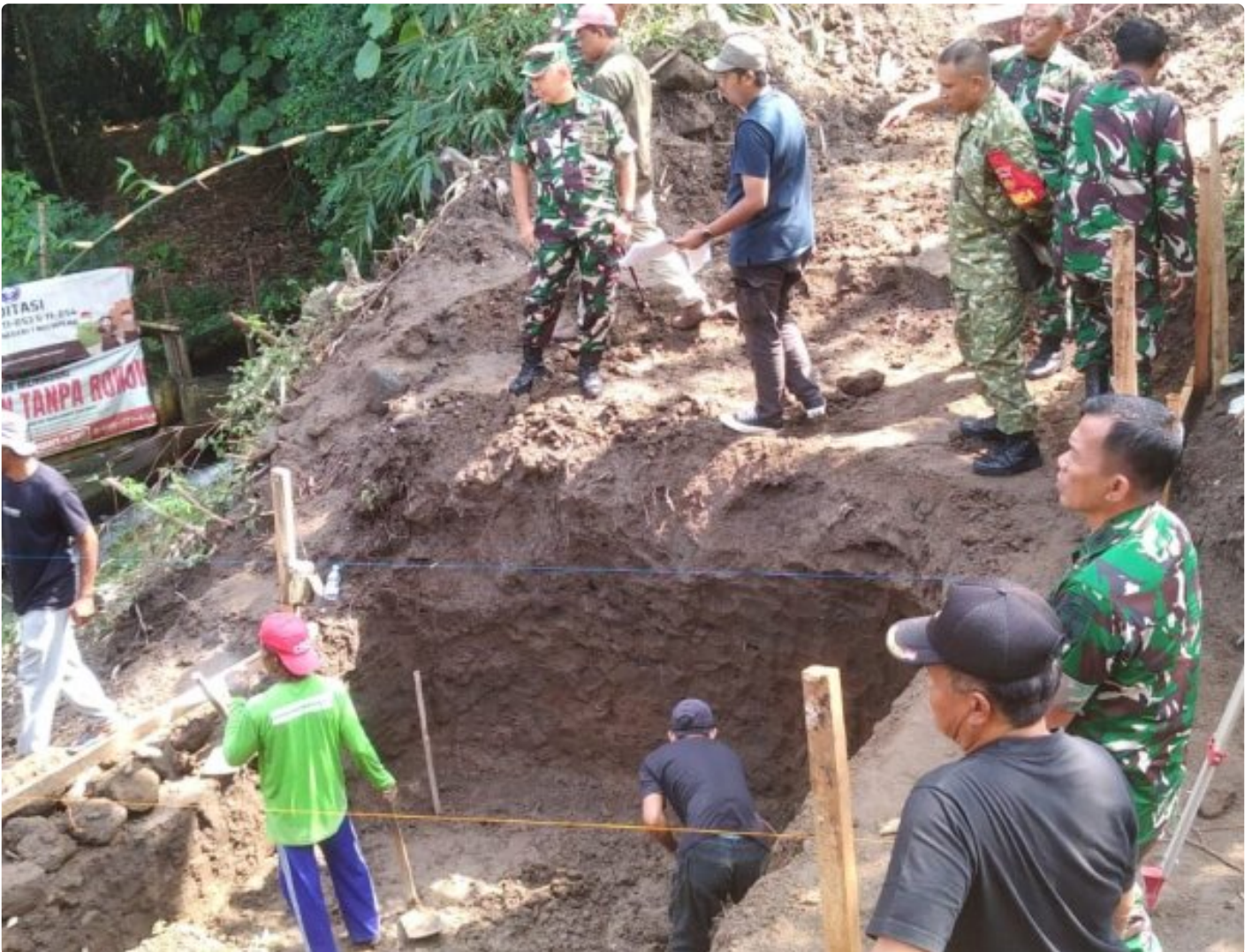
Dandenzibang Surakarta Tinjau Pembangunan Jembatan Garuda Perintis Di Klaten
