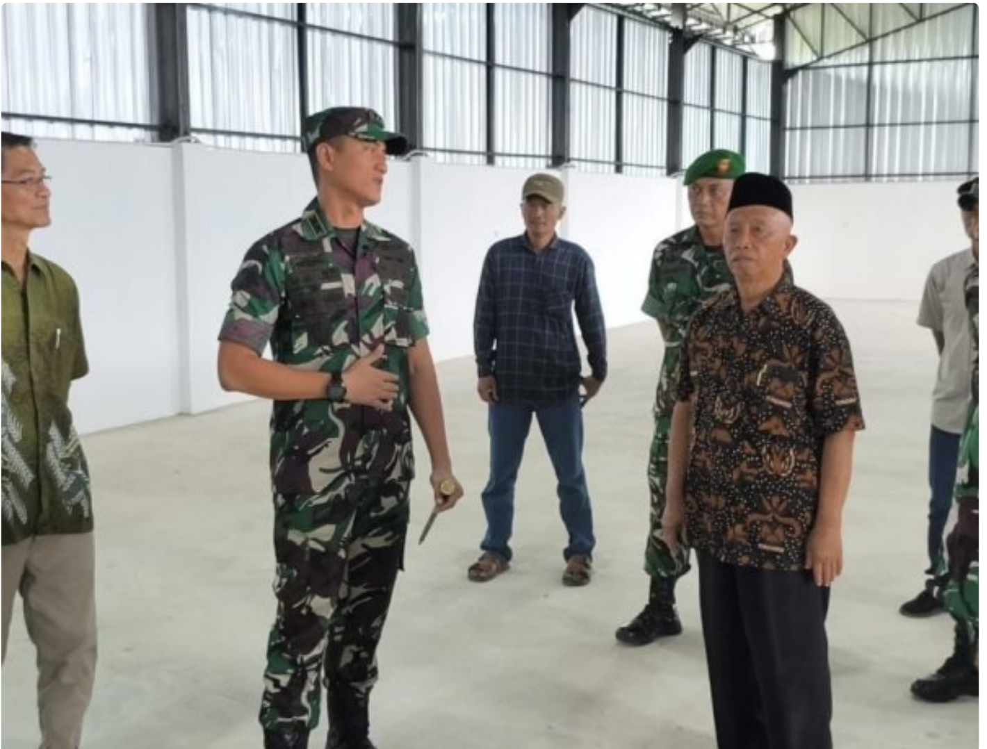
Dandim 0723/Klaten Tinjau Pembangunan KDKMP Di Candirejo, Ikuti Vicon Percepatan Bersama Wapang TNI
