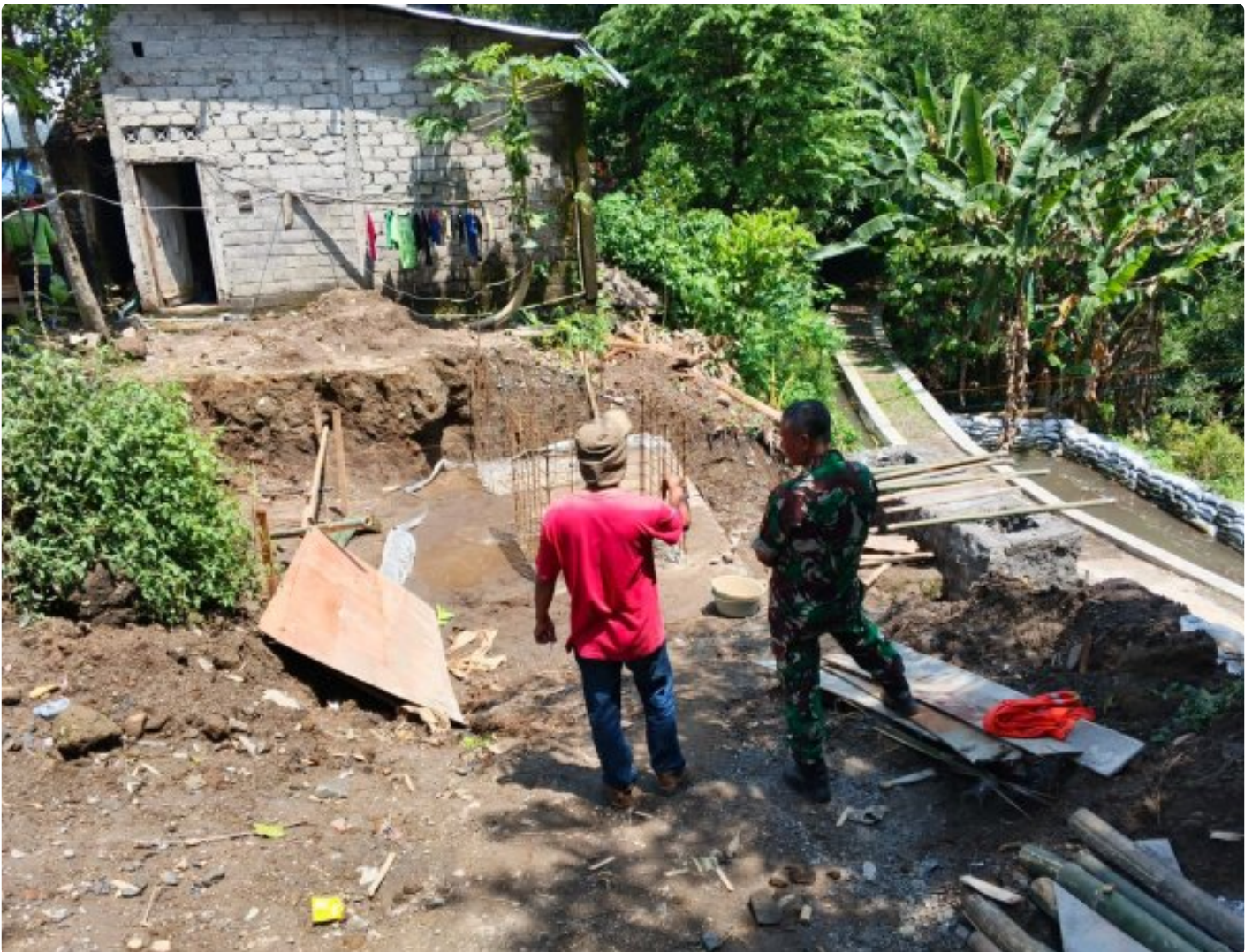
Danramil 12/Manisrenggo Pantau Pembangunan Jembatan Garuda Di Desa Kranggan
