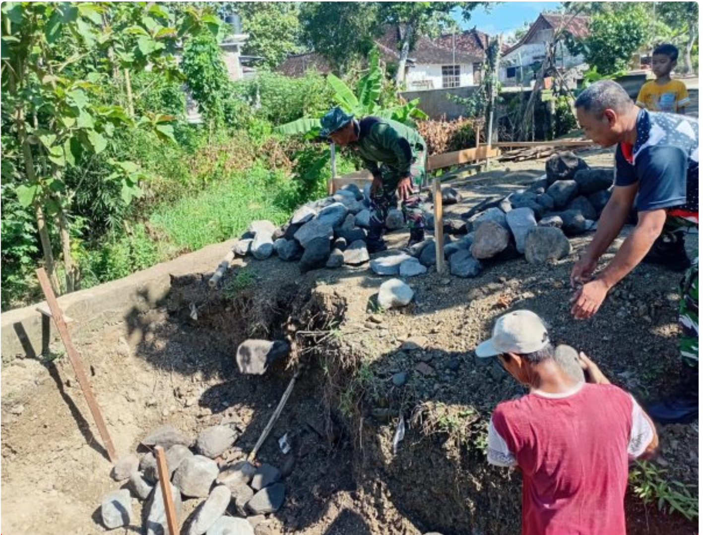
Gotong Royong Bangun Jembatan Garuda, Akses Trucuk–Bayat Kian Terbuka
