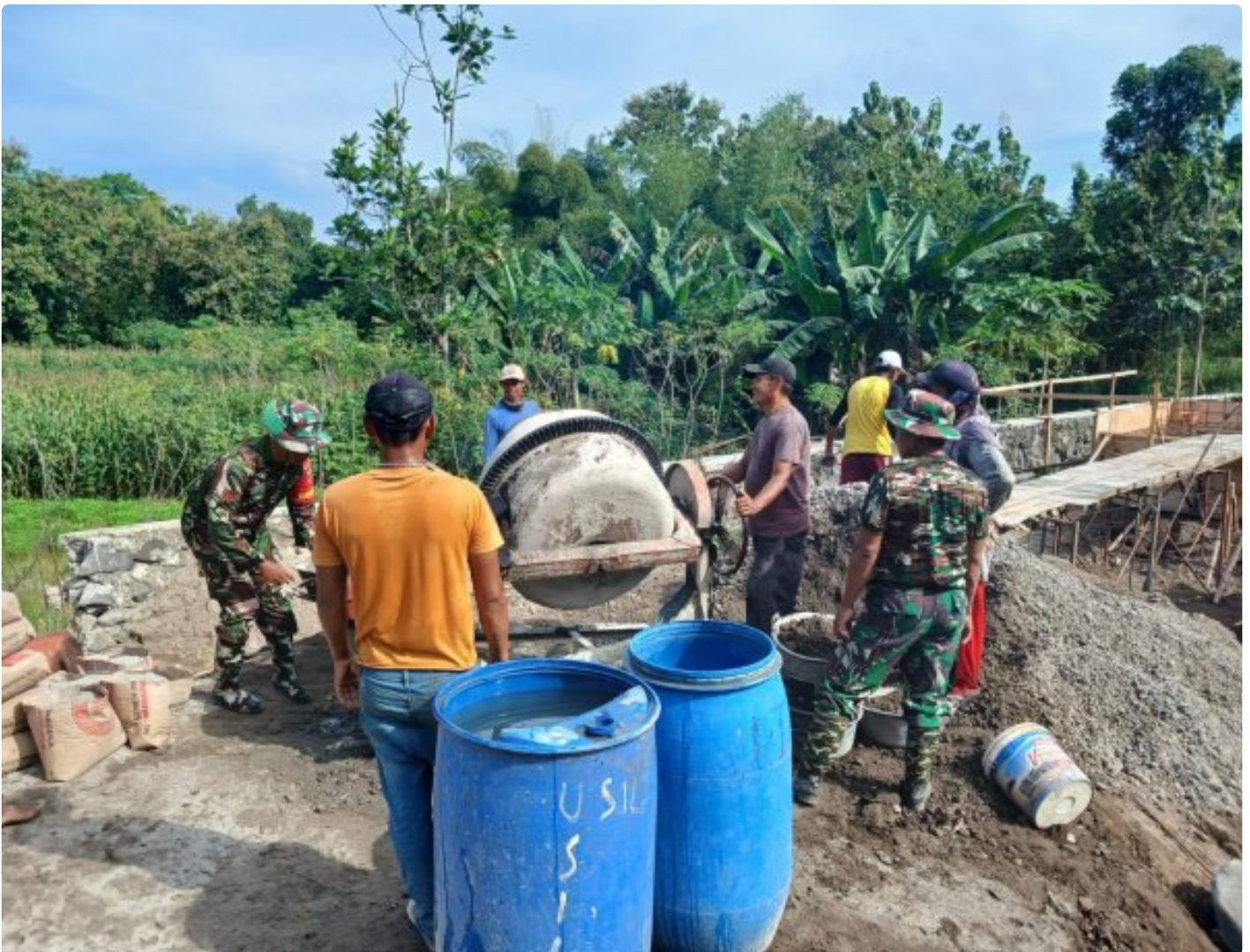
Gotong Royong Jadi Kunci Pembangunan Jembatan Garuda
