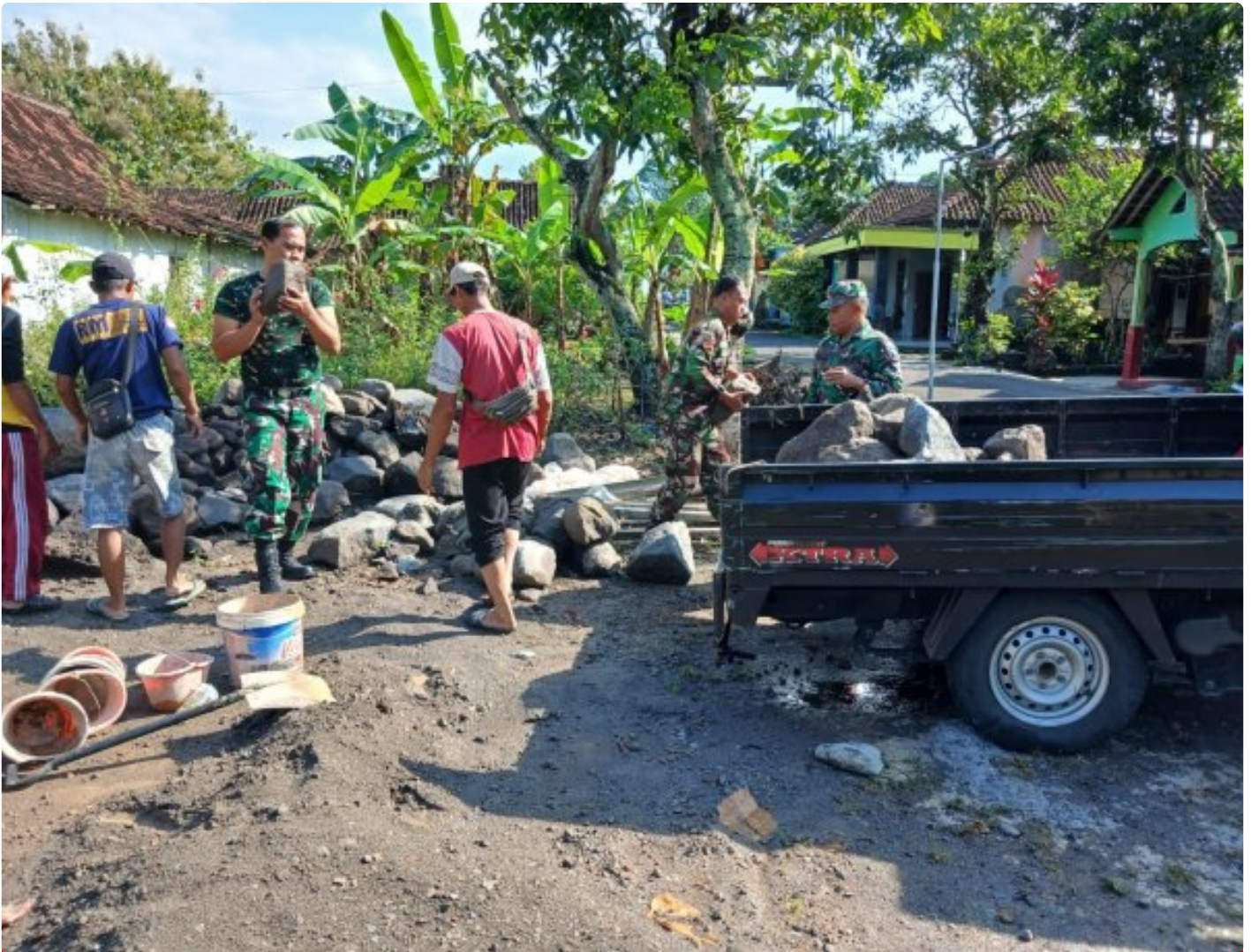
Gotong Royong Warga Dan TNI Bangun Jembatan Garuda Di Desa Karangpaket
