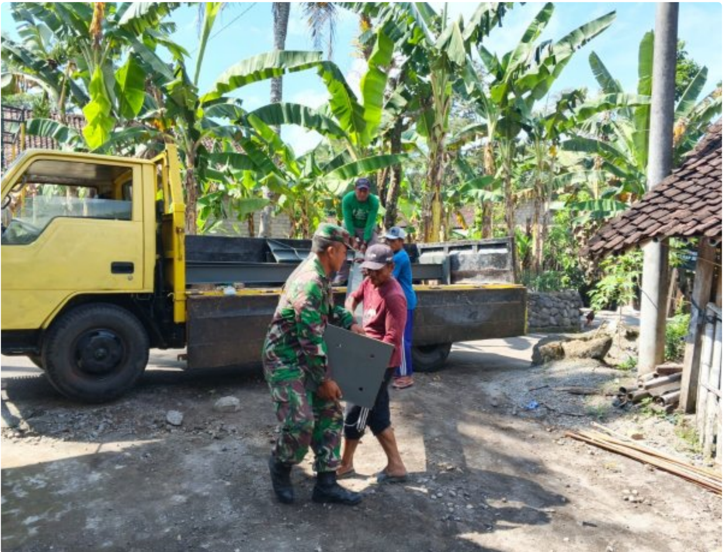
Kedatangan Tiang Pancang Jembatan Garuda Disambut Babinsa Dan Warga Kranggan
