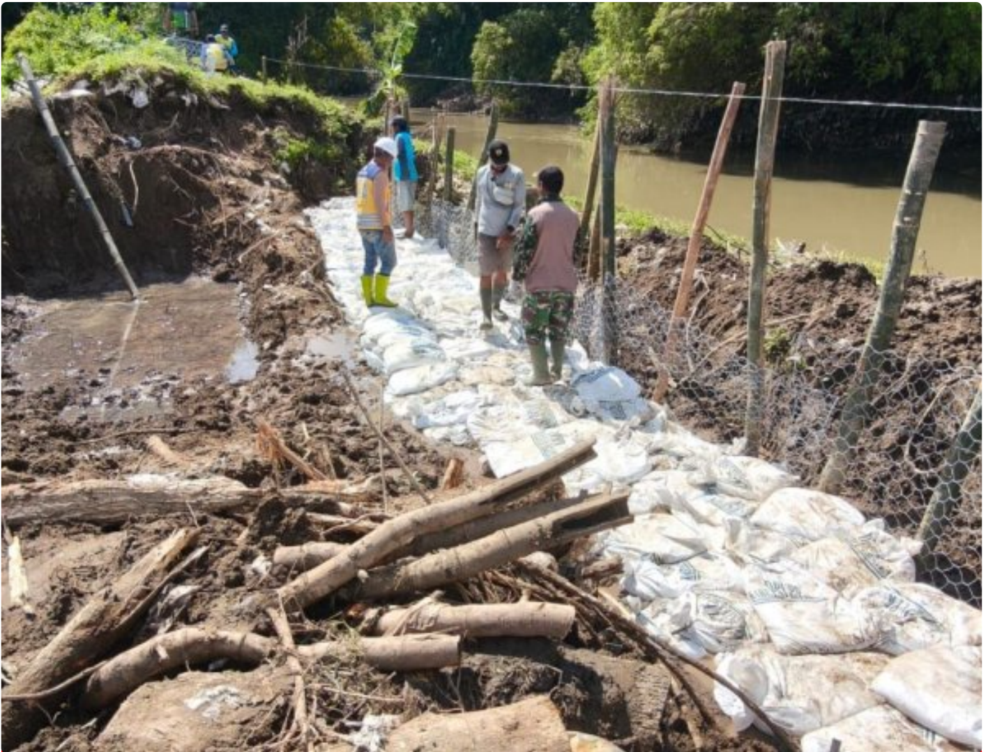
Koramil 20/Cawas Gotong Royong Perbaiki Tanggul Jebol Di Desa Japanan Cawas Klaten
