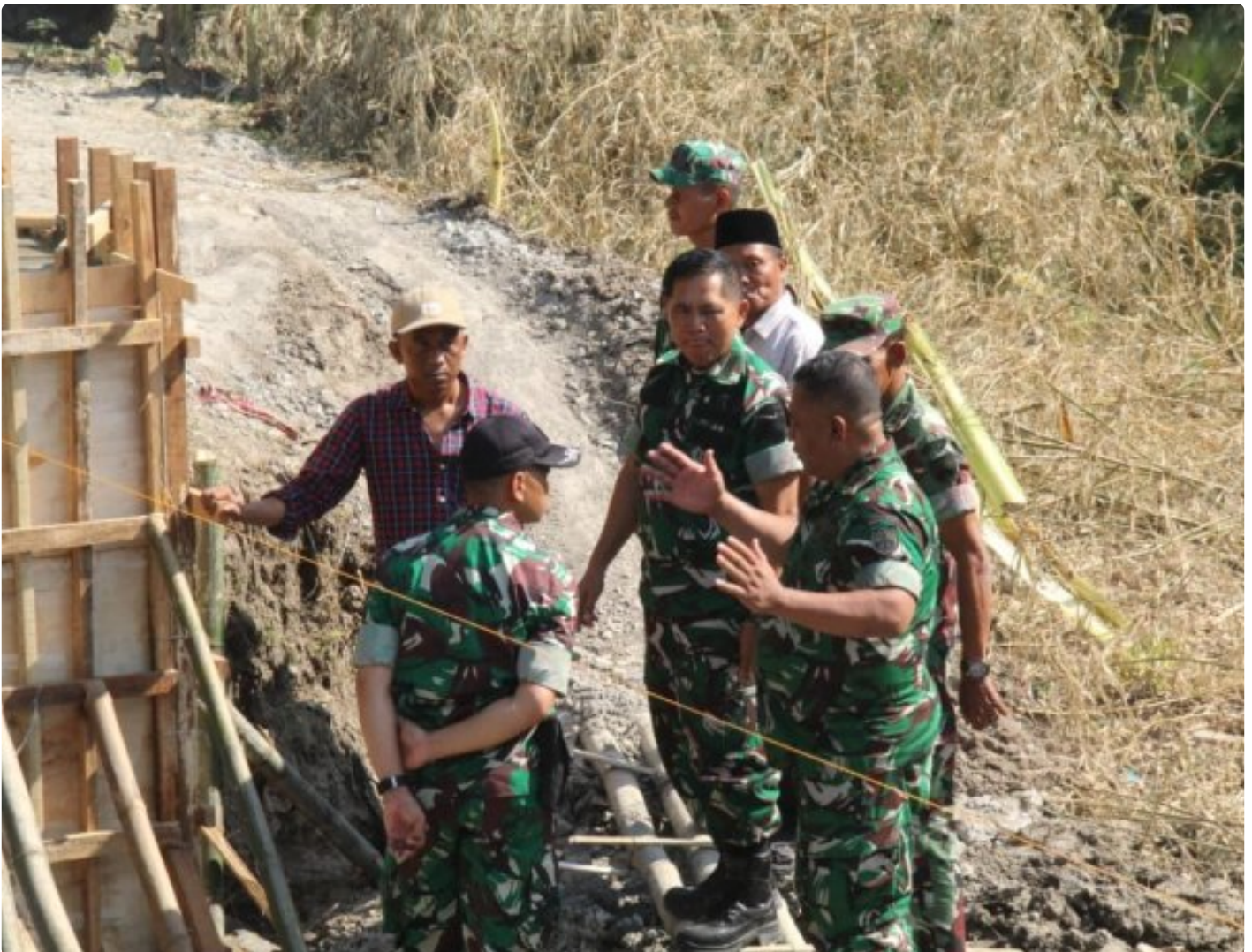
Monitoring Infrastruktur Di Klaten, TNI Pastikan Pembangunan Jembatan Sesuai Spesifikasi
