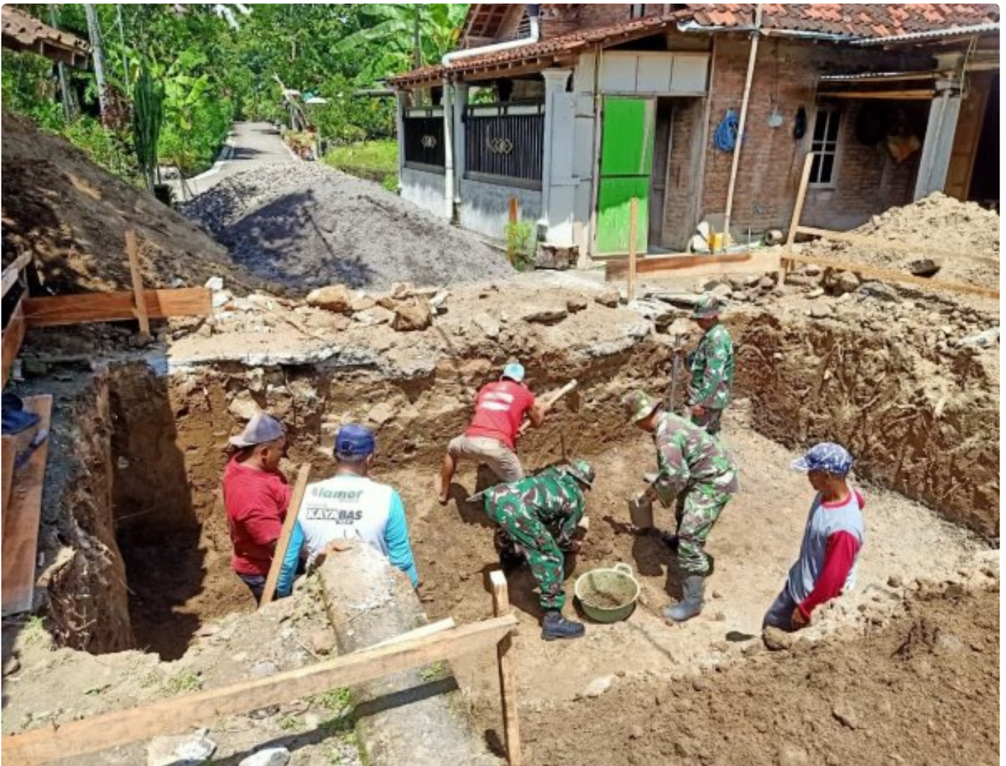
Pembangunan Jembatan Gantung Garuda Di Bayat Terus Dikebut, Progres Lampau Target
