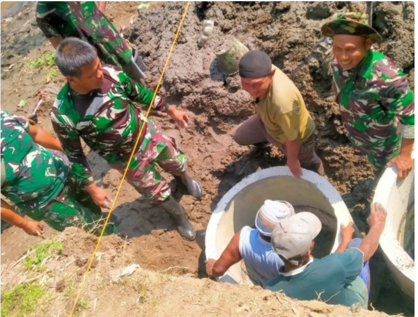
Pembangunan Jembatan Garuda Di Desa Burikan Masuki Tahap Pemasangan Bis Beton Pondasi
