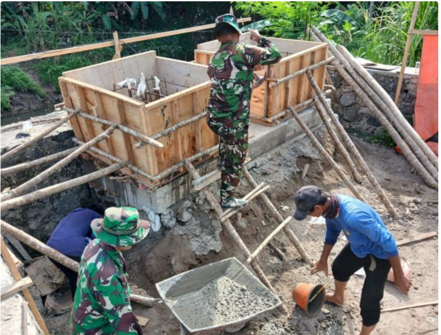
Pembangunan Jembatan Garuda di Desa Karangpakel Terus Berlanjut, Masuki Tahap Pengecoran Pylon
