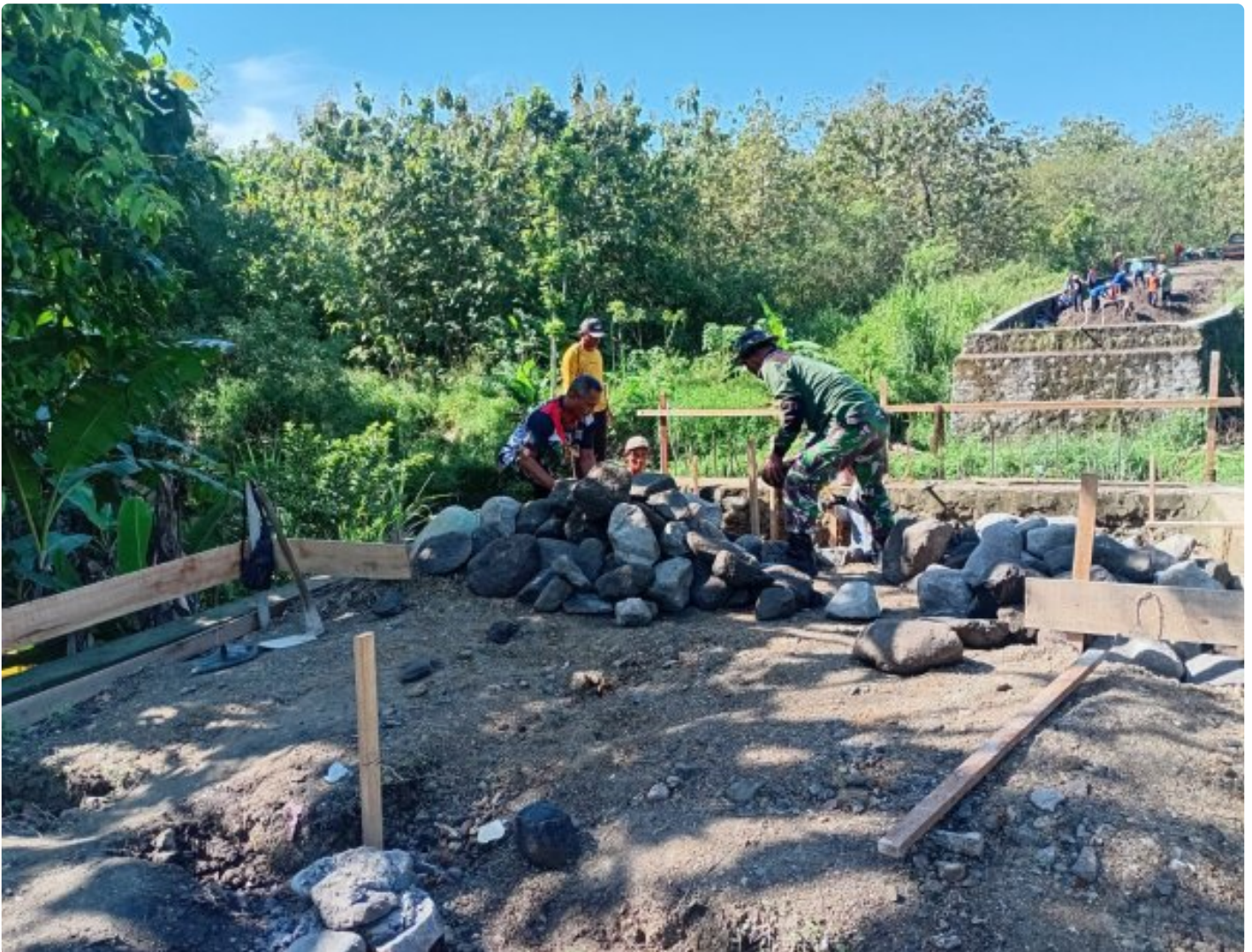
Pembangunan Jembatan Garuda Di Kedungkiri Terus Dikebut, Perkuat Akses Warga Trucuk–Bayat
