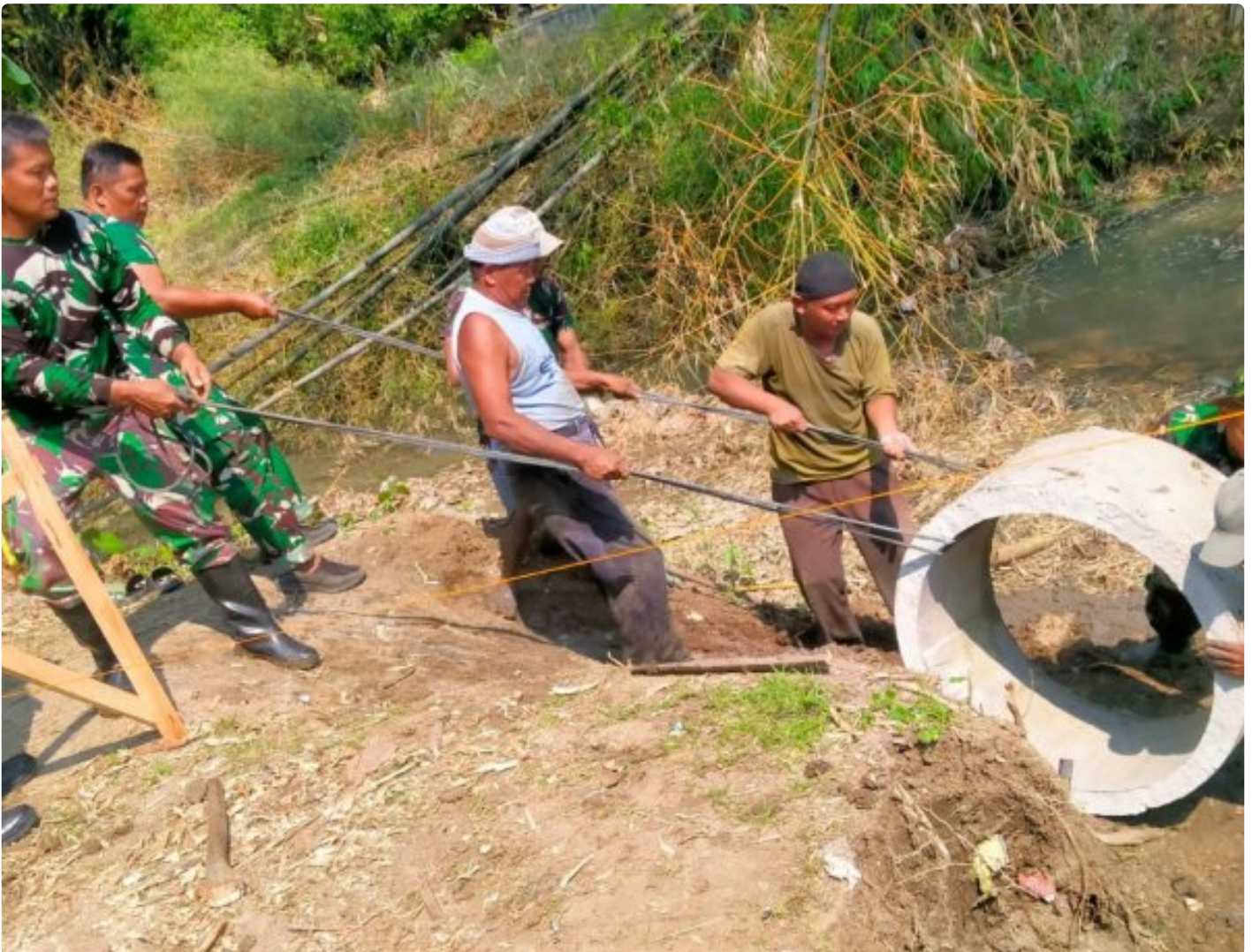
Semangat Gotong Royong Warga Warnai Pemasangan Bis Beton Jembatan Garuda Desa Burikan
