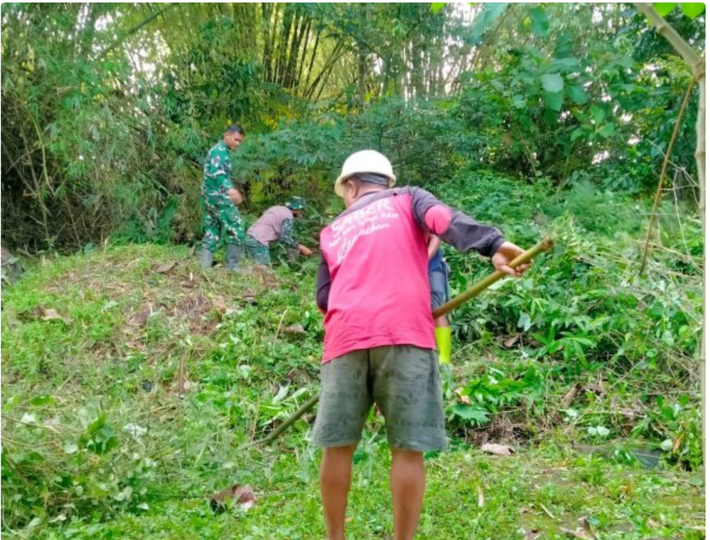
TNI Dan Warga Gotong Royong Bangun Jembatan Garuda, Akses Baru Di Burikan
