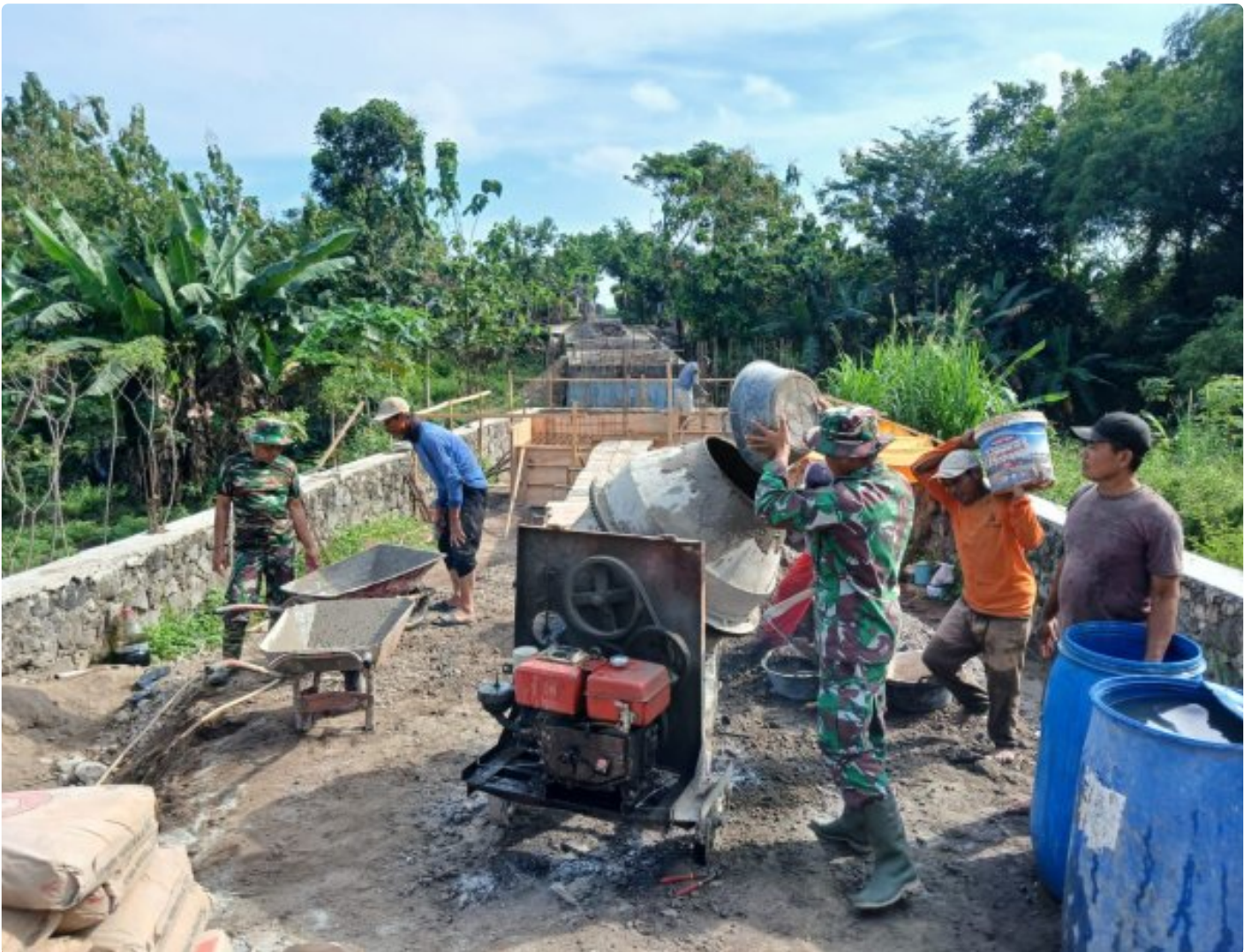
Warga Dan TNI Warnai Pengecoran Anchor Block Jembatan Garuda Di Karangpakel Klaten
